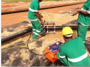
Solda do tubo PEAD - Testemunho
