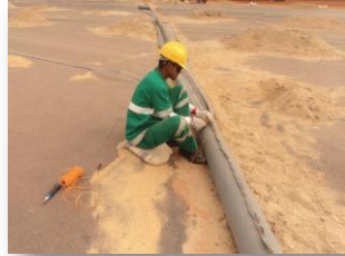
Geotêxtil envolvendo o tubo PEAD
