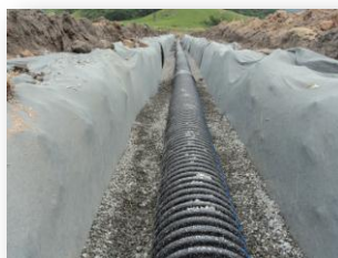
Preenchimento do dreno
