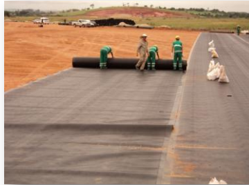
Abertura dos rolos de manta PEAD (1,5 mm)
