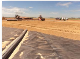
Aplicação da camada drenante
