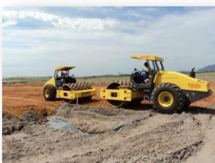
Regularização acima dos drenos Subsuperficiais
