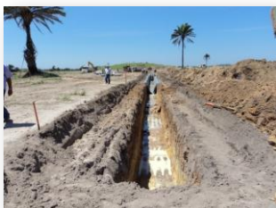
Abertura do dreno
