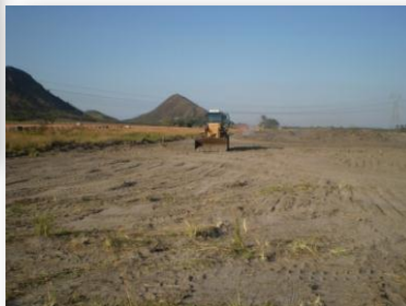
Limpeza da camada vegetal
