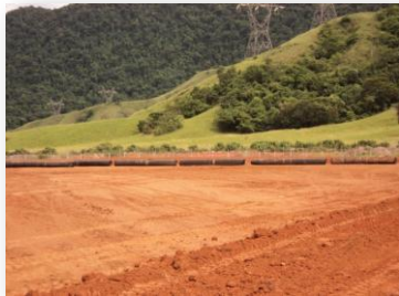
Abertura dos rolos de manta PEAD (1,5 mm)
