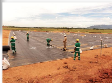
Solda da manta aplicada (Termofusão)
